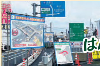
多治見IC改修工事視察
