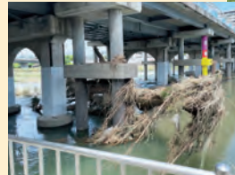
6月2日豪雨による 昭和橋橋脚対応
