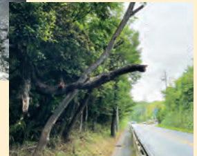
248号線倒木の危険ある 樹木の伐採対応
