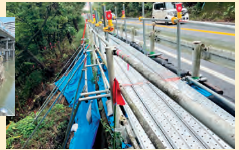
災害対応248号線歩道+法面改修対応
