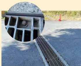
根本町 グレーチング側溝蓋対応
