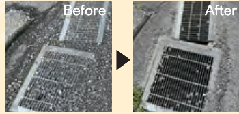
県道16号多治見犬山線:側溝詰り対応
