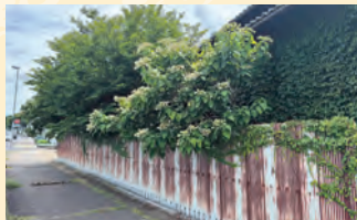
県道421号武並土岐多治見線 木伐採対応
