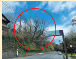
国道248号線倒木対策
